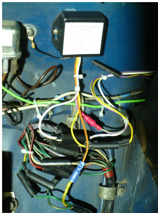
Nach dem Umbau: ODC2321 eingebaut
