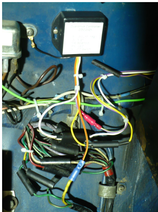
Nach dem Umbau: ODC2321 eingebaut
